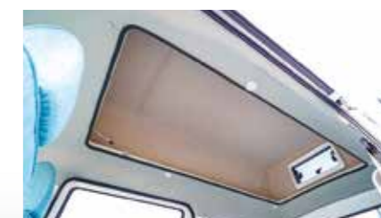
内側断熱材で快適性、防音性を向上
